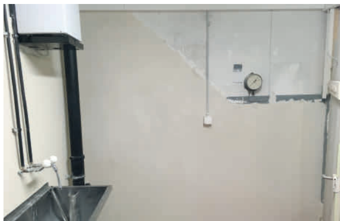
Keller nach der Sanierung mit neuem Putz
