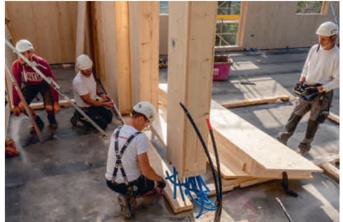
Montage der vorgefertigten Wandelemente mit eingebauter Elektrovorbereitung vor Ort
