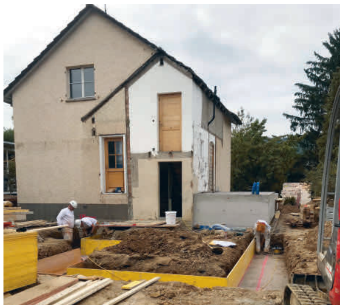
Das bestehende Haus wird durch einen «Schopfanbau» erweitert
