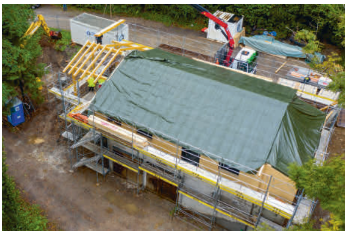
Luftaufnahme während den Bauarbeiten
