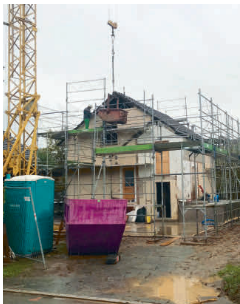
Arbeiten am ursprünglichen Hausteil
