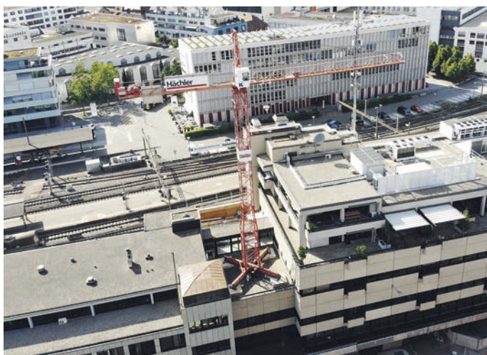
Baukran auf dem Hausdach beim Badener Postareal
