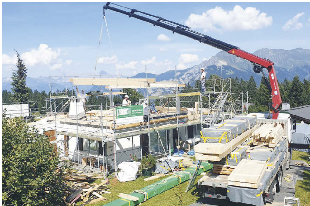
Baustelle in Malix (GR), oberhalb von Chur
