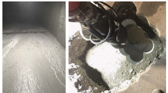
Betonierarbeiten am unterirdischen Schacht.
