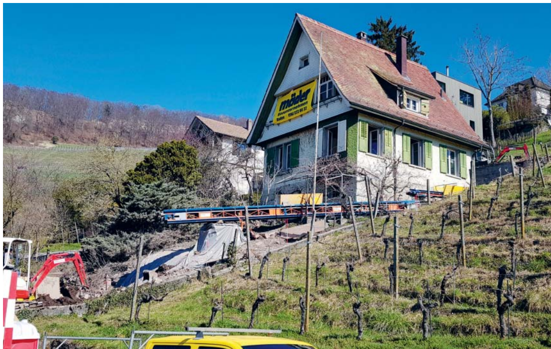
Das Haus am Rebberg während den Umbau- und Tiefbauarbeiten
