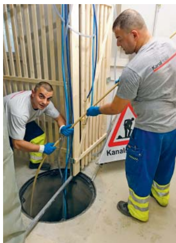
Kanalsanierung mit Rohrrenova AG
