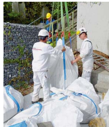
Betonstücke werden abtransportiert
