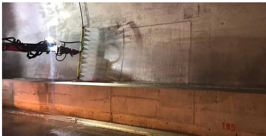
Tunnelreinigung mit Franz Pfister AG.
