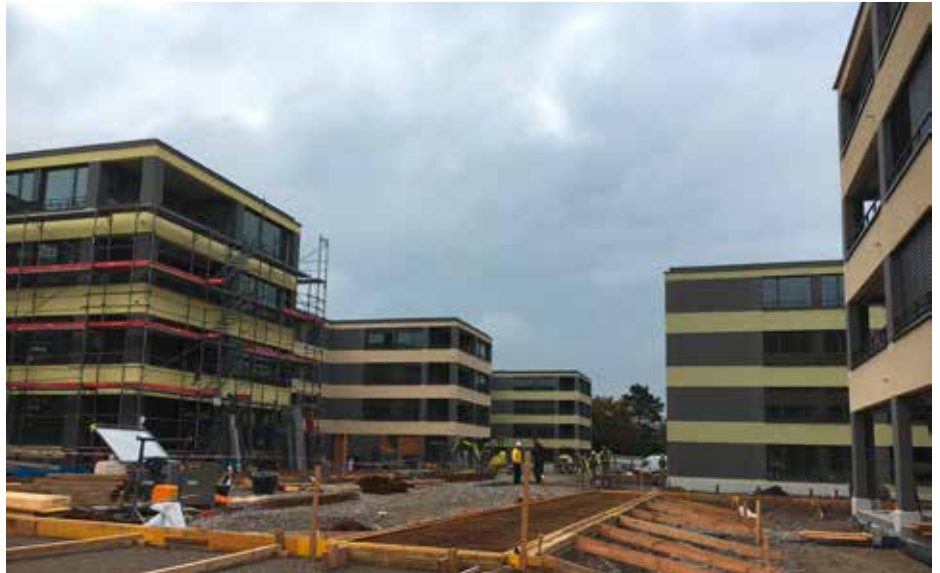
Teilansicht der fast fertigen Überbauung.
