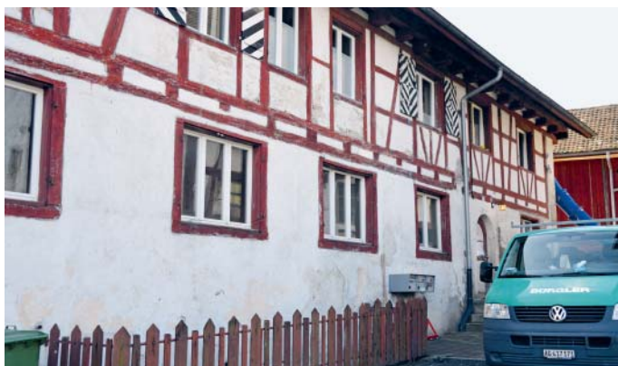
Die Vorderseite des Hauses – Fassade vor der Sanierung.
