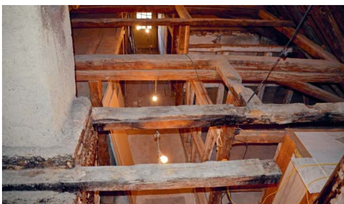
Imposanter Holzwerkbau im Dachstock, der in eine Wohnung umgebaut wird.
