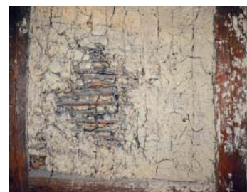
Baugeschichte pur: Holzgeflecht mit Lehmwickel verfüllt.
