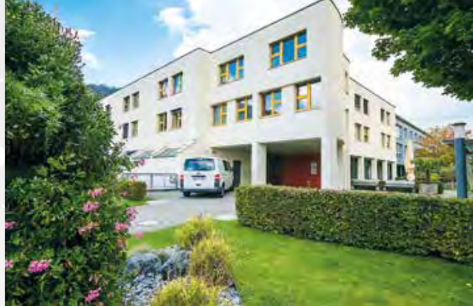
Das Wohnheim Kirchzegg an der St. Bernhardstrasse in Wettingen.
