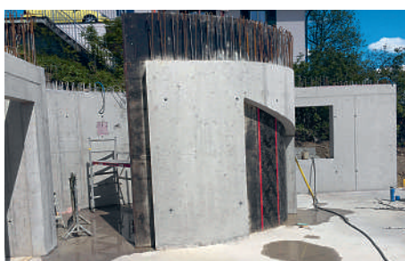
(oben links) Die Schalung für den ovalen Treppenaufgang. (unten links) Der Treppenaufgang betoniert. (rechts) Treppenaufgang: Sicht von unten.
