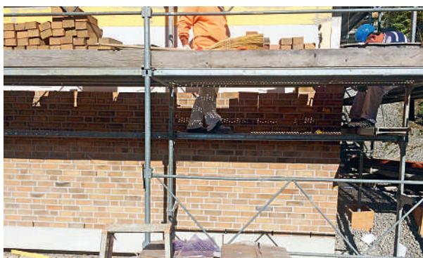
Das Sichtmauerwerk nimmt Formen an.
