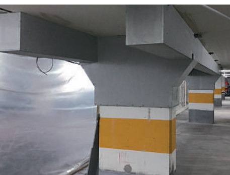
Stahlpilze mit Betonträger.
