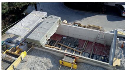
Pool in Arbeit (Sicht vom Haus aus).
