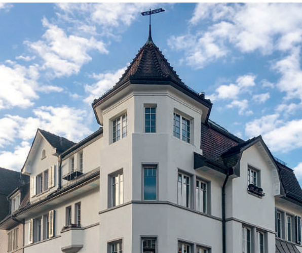
Die oberste Wohnung wurde renoviert.
